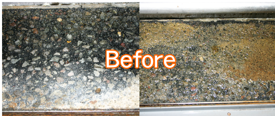
長年の使用で荒れたコンクリート表面
