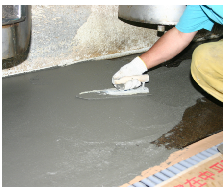
④K.Y.F樹脂を混入、施工します。
